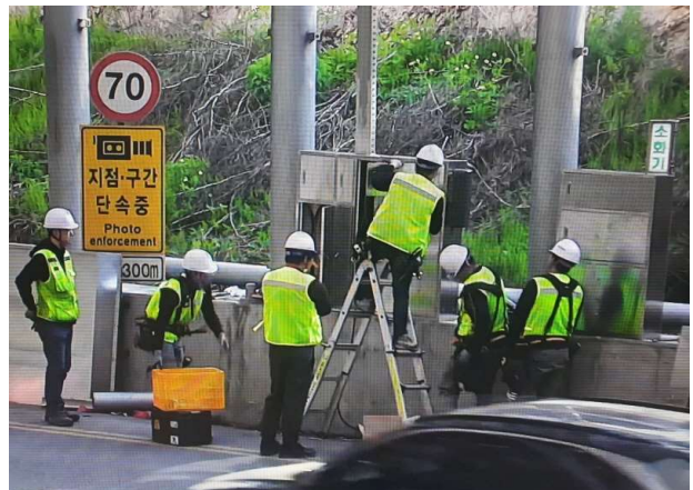
보수 및 위치 변경 작업(중계기 설치)
