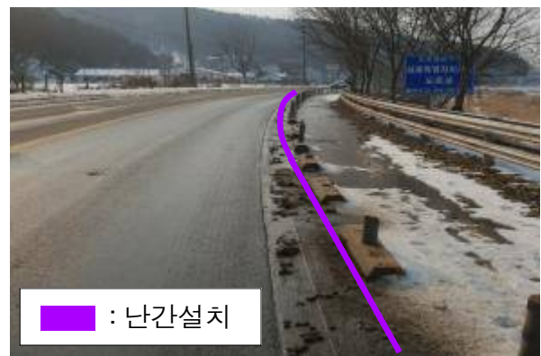
시설 유도봉 철거 안전난간 설치
